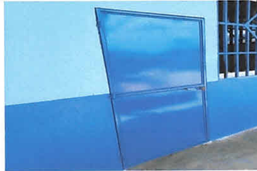
Foto 4: Remozamiento e instalacion de nuevas chapas en puertas
