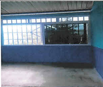
Foto 3: construccion e instalacion de ventanas
