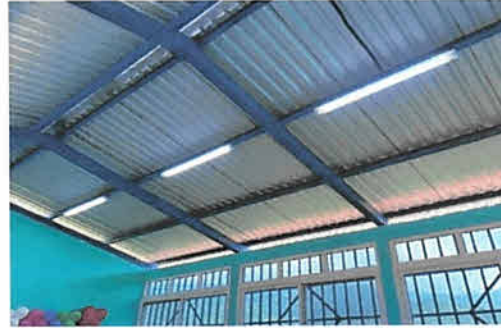
Foto 2: instalacion de nuevas lamparas
