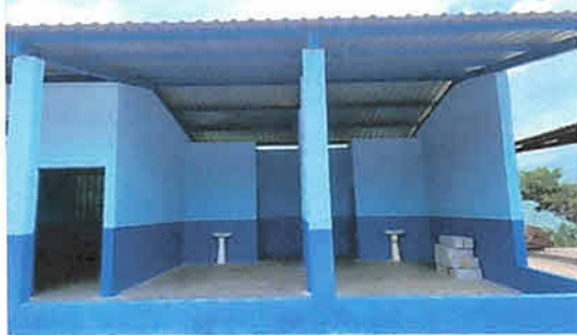
Foto 5: Remozamiento y habilitacion de lavamanos
