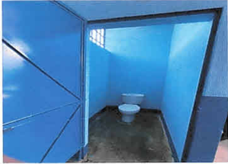
Foto1: Remozamiento y habilitación de servicios sanitarios
